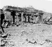
▲「破壊された与那原駅（1945年）」06-44-1
