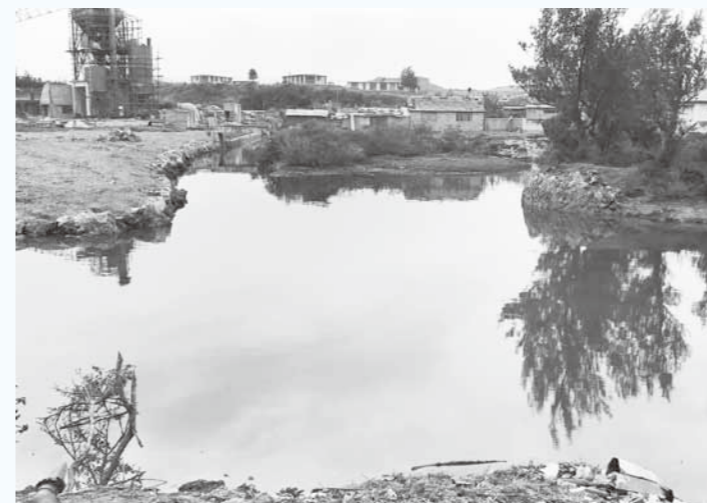
③空中写真の黄矢印付近(安謝川)から米軍住宅方面を撮影したと思われます (1964年) (写真番号:005803)
